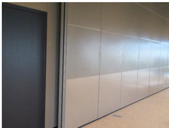
⑩西側壁面に、可動壁が収納されています 手前に見えるのは、小会議室 406 への扉
