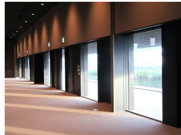
⑨ロビーに面したガラス壁 ガラス越しに新幹線の高架が見えます
