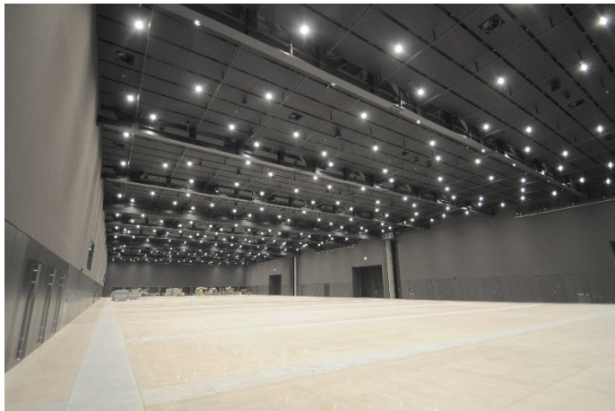
①展示場 A 手前側より全景 コンクリート床に、ピットが設置されています
