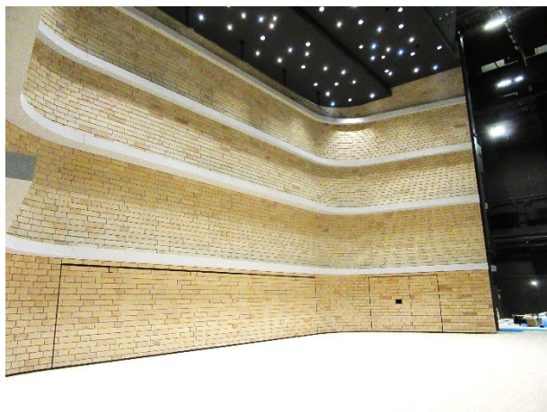
⑤舞台奥の懸垂走行式音響反射板 （舞台後方へ収納した状態）
