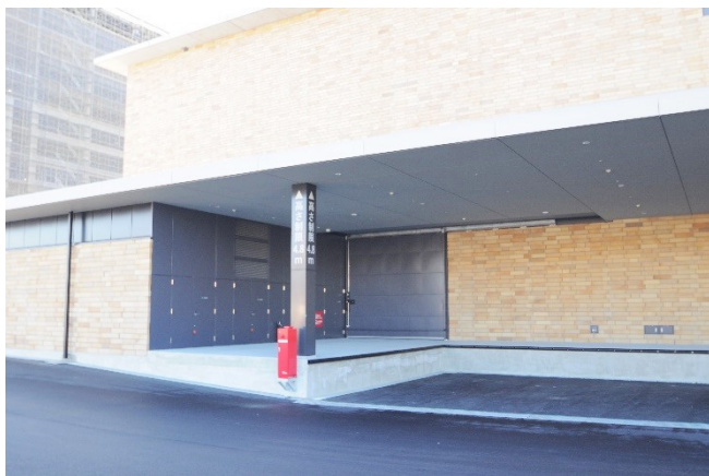
大ホール搬入ヤード全景 10t車が2台まで留め置きできます
