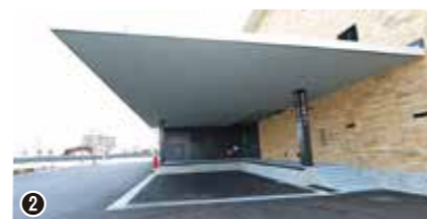
② 大ホール搬入口
