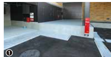
① 中ホール搬入口
